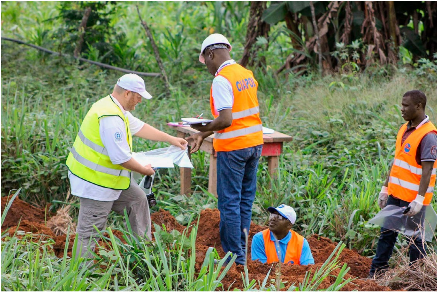
Bodenprobenahme in verschiedenen Tiefen an einem der sanierten Standorte in Abidjan.
